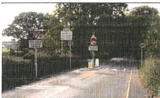
Εικόνα 27: Αλλαγή-μείωση ορίων ταχύτητας με χρήση ανάλογης σήμανσης
